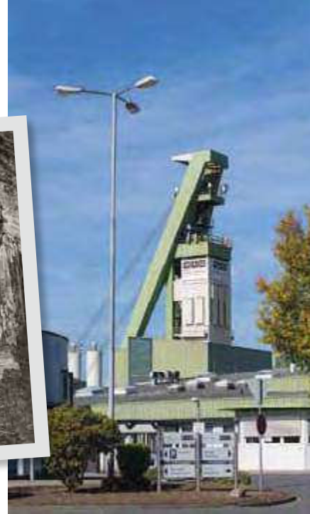
Im Bergwerk Prosper-Haniel schloss der letzte nicht nur die Tür, sondern auch eine Ära
