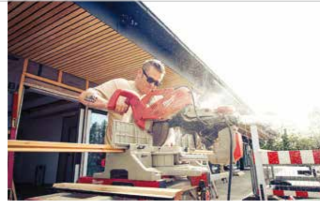
Ein Struwe-Mitarbeiter beim Herstellen einer Holzfassade.
