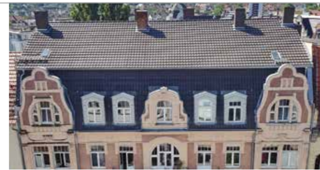
Steildachsanieierung an einem historischen Gebäude in Kassel.
