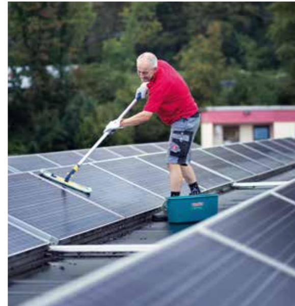
Auch eine wichtige Arbeit: Die abschließende Reinigung der PV-Module.
