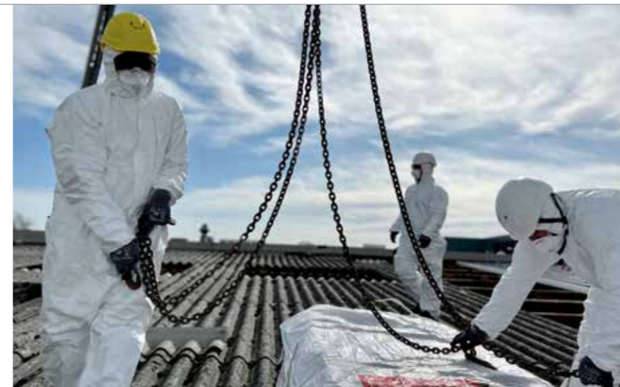
Die Atemschutzmaske ist Pflicht, wenn gefährliche Stoffe beim Abriss eines Daches im Spiel sind.
