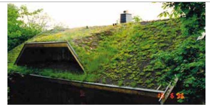
Auch Gründach-Projekte werden seit Jahrzehnten ausgeführt, hier eines aus dem Jahr 1996 von der Rainer Bärwald Dachdeckermeister GmbH.
