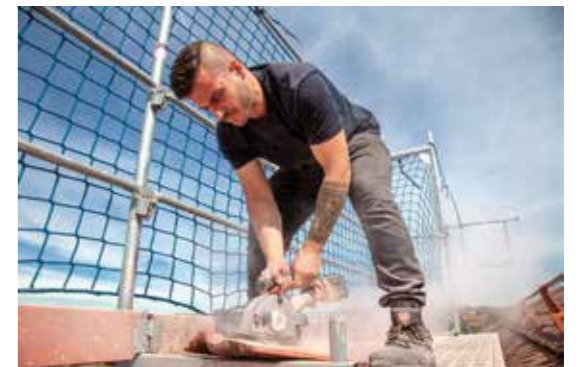
Ein Struwe-Mitarbeiter beim Bearbeiten eines Dachsteins.
