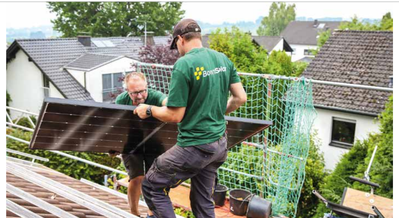
PV-Montage auf dem Steildach: Mitarbeiter von BonnSolar im Einsatz.
