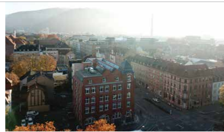
Denkmalsanierung einer alten Tabakfabrik in Heidelberg mit Sheds und großen Dachfenstern.
