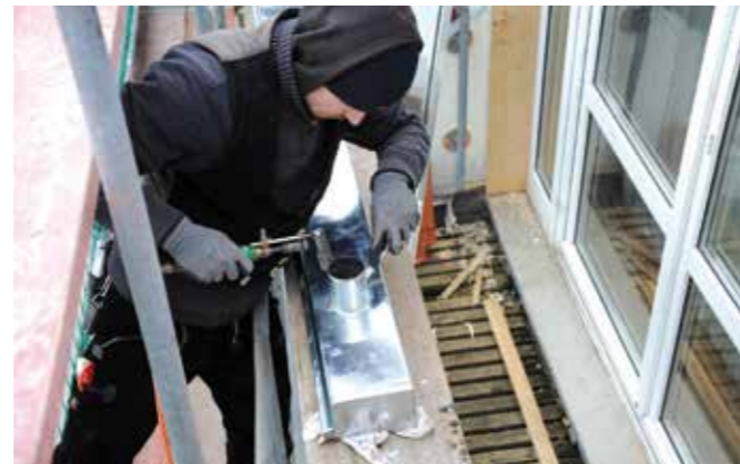
Entwässerungsrinnen werden vor Ort passgerecht zugeschnitten und gelötet. Der Geselle schneidet runde Ausschnitte in die Rinne und das Fallrohr wird direkt angesetzt und am Rand verlötet.
