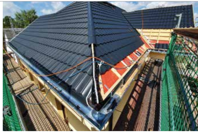
Große Bogenfirste sind auch für den Walm geeignet, der dann mit einer Anfangskappe abgeschlossen wird.
