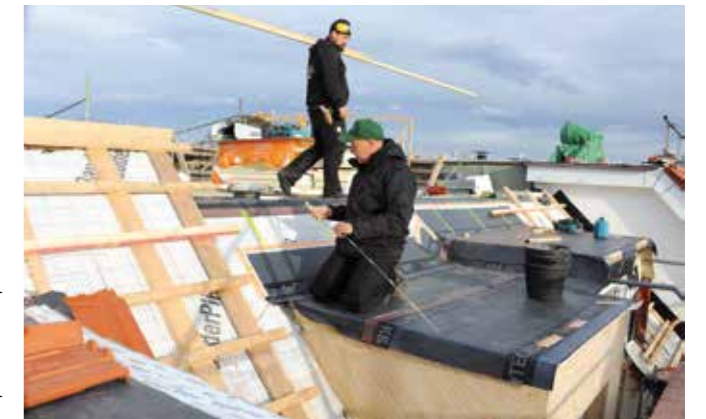
140 Millimeter Dämmung auch für die Gauben unter der Holzverschalung.
