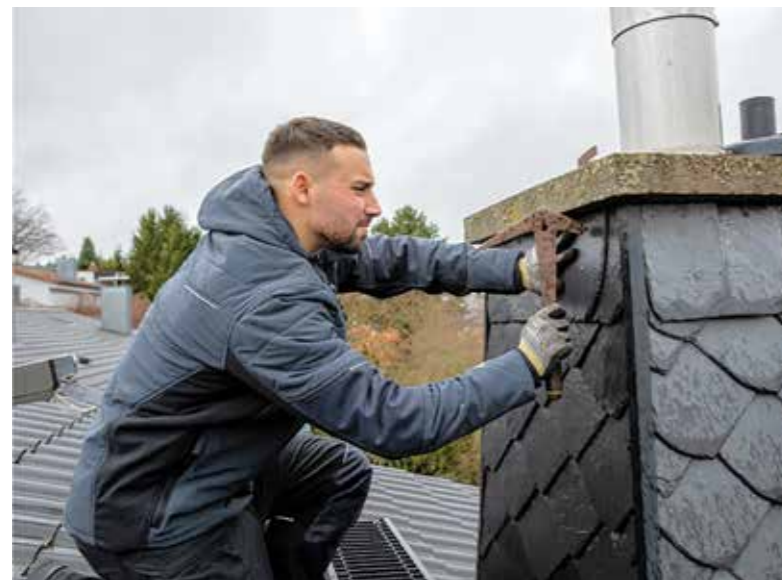
Mit seinem eigenen Betrieb übernimmt der Dachdeckermeister auch vielfältige Reparaturarbeiten.
