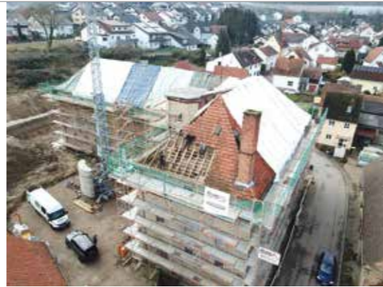
Denkmalsanierung eines Daches mit 1500 Quadratmeter Fläche in Dielheim.
