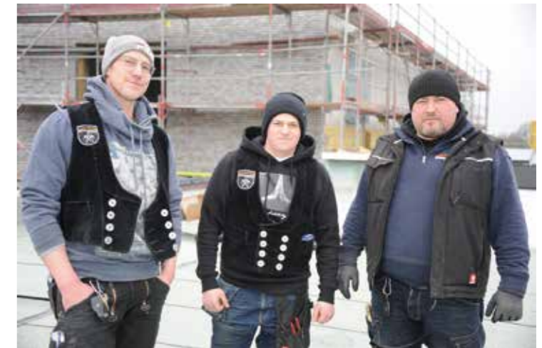
Die Mitarbeiter Marcus Ganzer, Kevin Wöllner, Max Welker (von links) auf der Baustelle eines Neubaus der Oberschule an der Lerchenstraße in Bremen-Nord.
