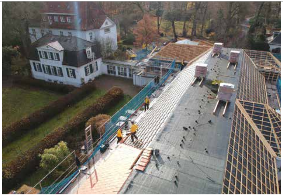
Der Betrieb ist ein klassischer Allrounder – hier zu sehen eine größere Steildachsanierung.
