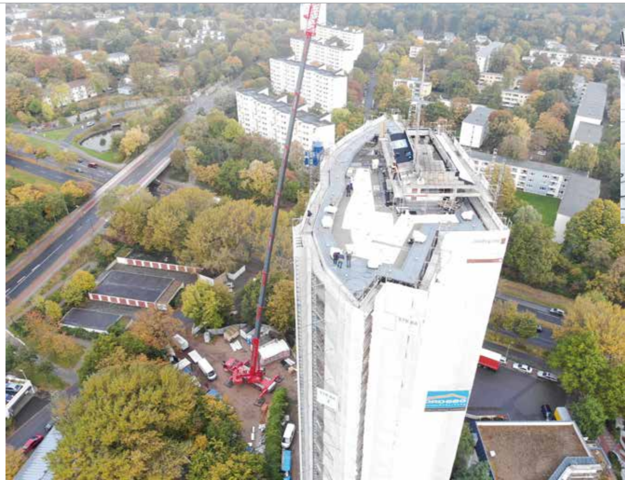
Vorzeigeobjekt: Flachdachsanieierung auf dem Aalto-Hochhaus in Bremen-Vahr.
