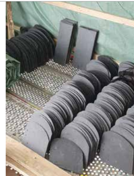
Das Material für die Schiefereindeckung liegt bereit.
