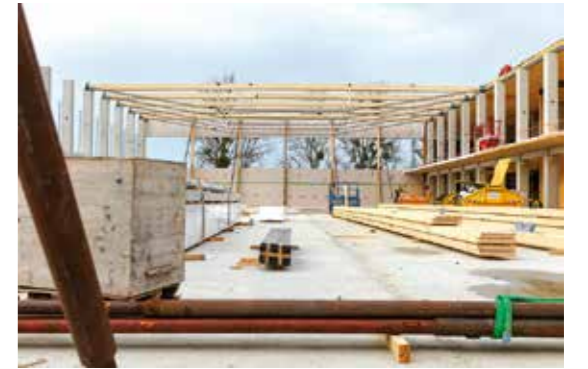
Eine Binderkonstruktion aus Holz bildet das Hallendach.
