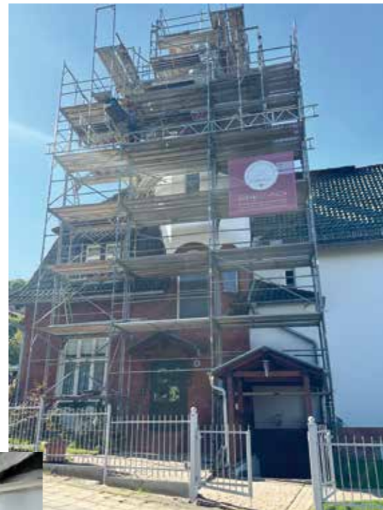
Jede Dachschindel ist ein Unikat. Ein Mitarbeiter bei der Arbeit am voll eingerüsteten Turm.
