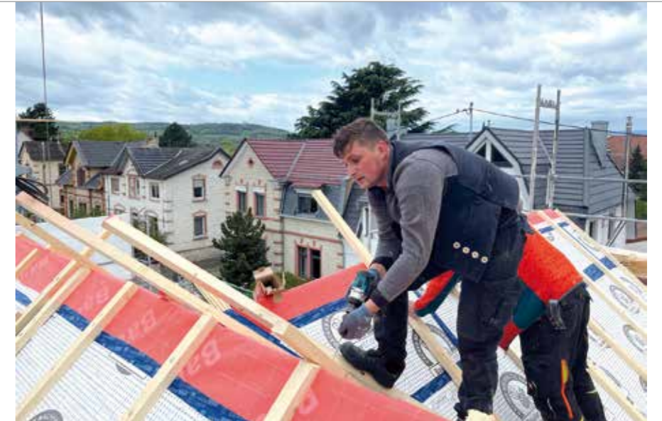
Mitarbeiter bei der energetischen Steildachsanieurung.
