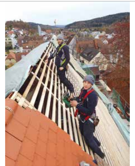
Dachdeckergeselle Daniel (hinten) und Azubi Alfredo decken die Stadtkirche Lorch ein.
