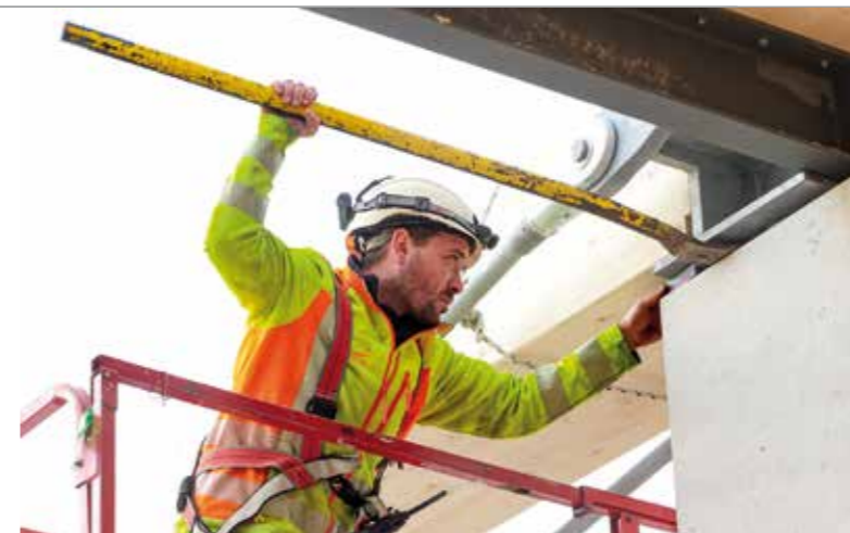
Die tonnenschweren Dachelemente werden in Position gebracht.
