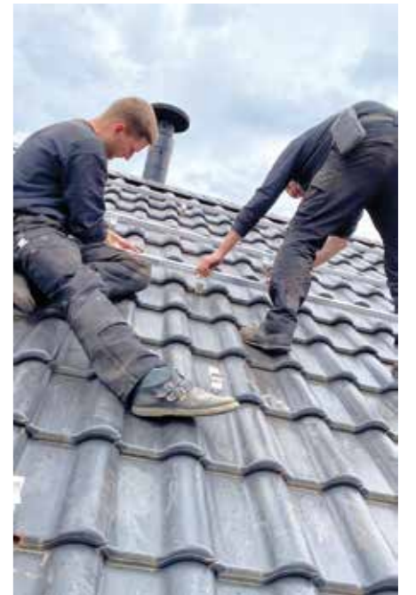
Nach dem Setzen der Dachhaken befestigen die Mitarbeiter die Schienen für die Module.
