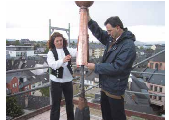
Dachdeckermeisterin Karin Oster befestigt eine kleine Kupferspitze auf der Baustelle.
