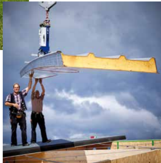
Das Hallendach inklusive Dämmung fliegt per Kran ein.
