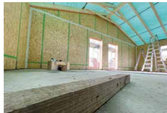
Dachstuhl und Wände stehen schon bei der Dachaufstockung.
