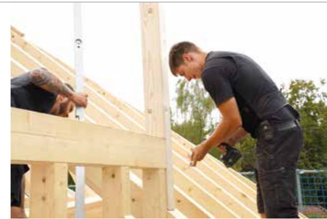
Die Mitarbeiter beim Erstellen eines Dachstuhl.
