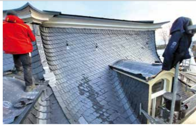
Ein Jahr Arbeit auf dem Dach
