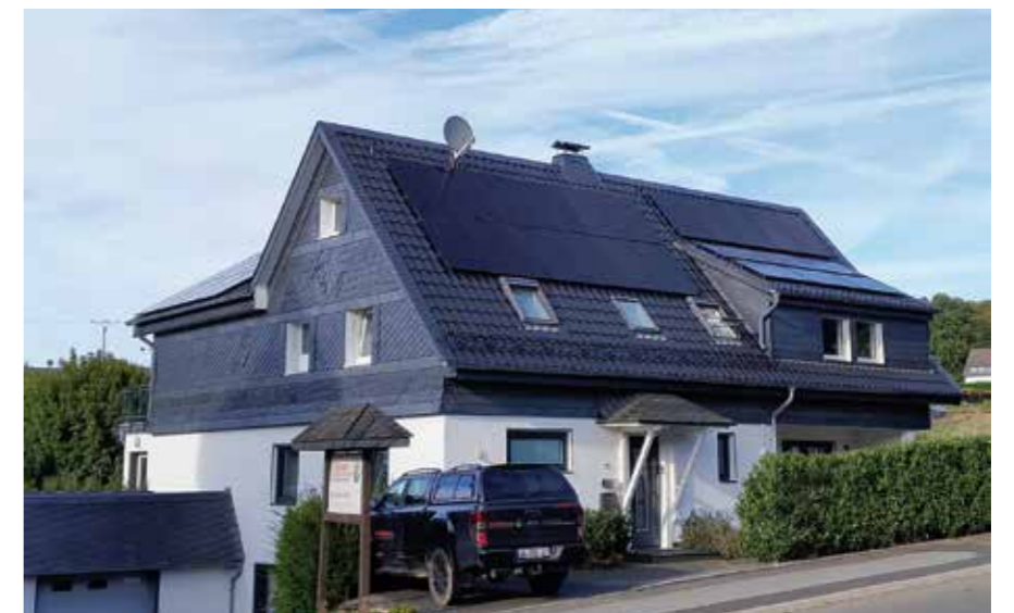
Das erste PV-Projekt von Marc Clemens: Eine Anlage auf dem Dach des eigenen Wohnhauses
