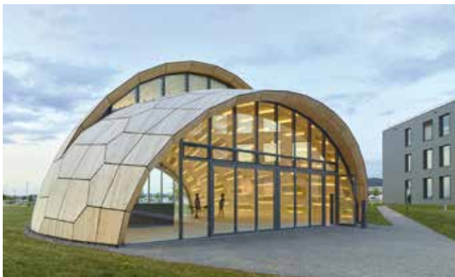
Außenansicht des innovativen Holzpavillons.
