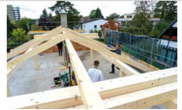
Eine komplette Aufstockung um eine Etage inklusive Dachstuhl und Eindeckung.
