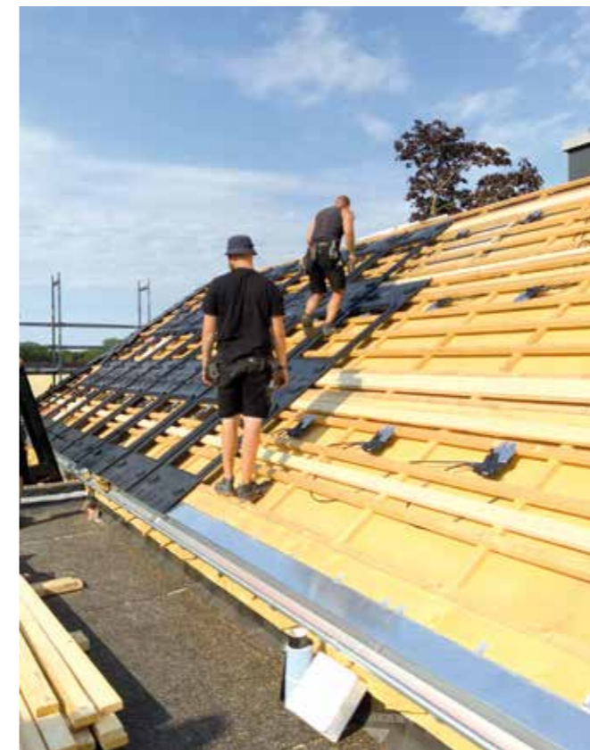
Mitarbeiter montieren eine Indach PV-Anlage auf dem Steildach.
