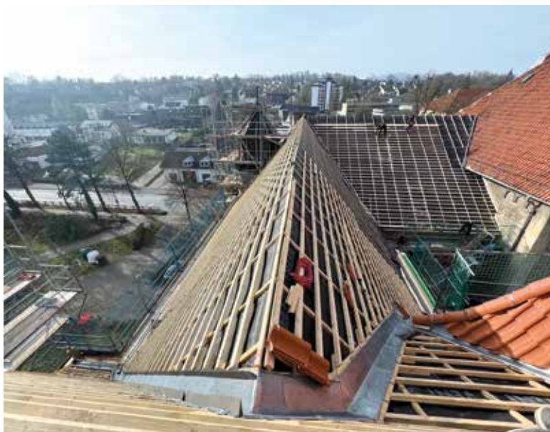
Ein Großprojekt: die Dachsanierung des Altbaus des Leopoldinums, des ältesten Gymnasiums Detmolds.
