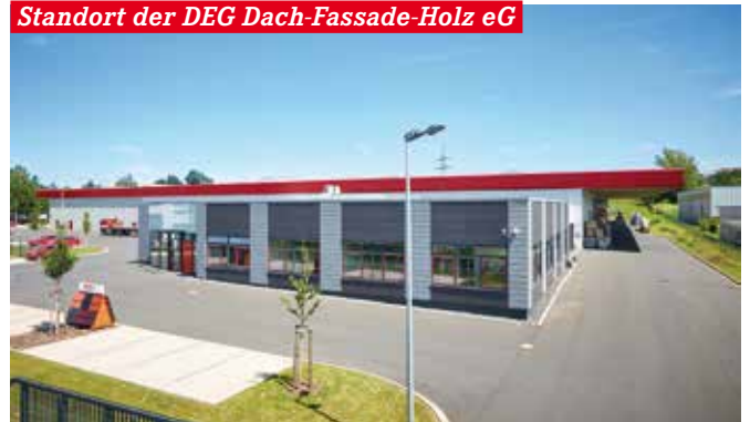
Zweigniederlassung Fuldabrück - größter Standort der DEG Dach-Fassade-Holz eG
