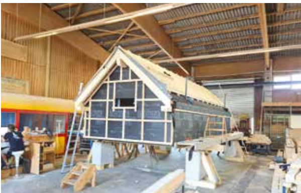
Vorfertigung Tiny House in der Produktionshalle von Zultner Holzbau.
