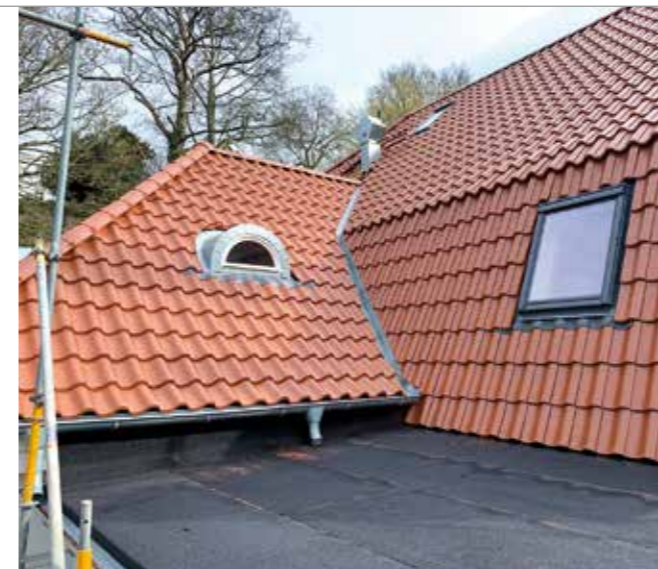
Das Dachdecker-Team saniert eine unter Denkmalschutz stehende Villa an der Elbe in Hamburg.
