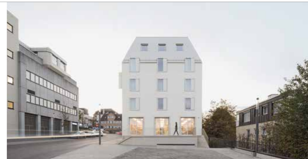
Das für den deutschen Nachhaltigkeitspreis Architektur 2021 nominierte Hotel in Ludwigsburg wurde vom Architekturbüro VON M mit einem sogenannten Cool Roof ausgestattet.
