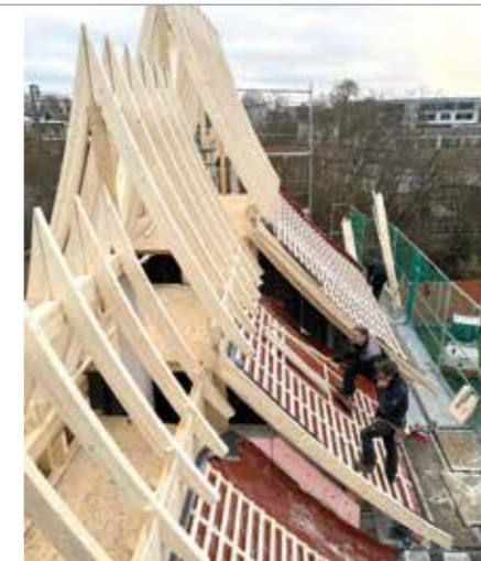
Die gebogenen Sonderträger ragen steil nach oben und sorgen für eine Dachhöhe von zehn Metern.
