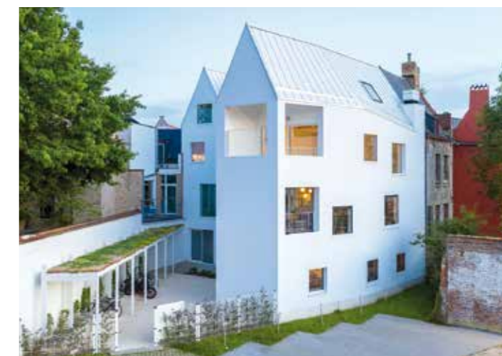
Im historischen Zentrum von Mechelen schlossen dmvA architecten eine Baulücke durch ein Mehrfamilienhaus mit spitzem Dach und gänzlich weißer Farbgebung.
