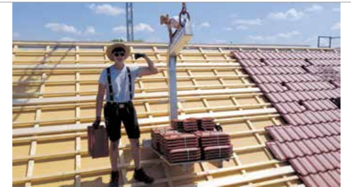
Lehrling Marcel Benecke hat Spaß bei der Arbeit, die Materialien kommen per Kran aufs Dach.
