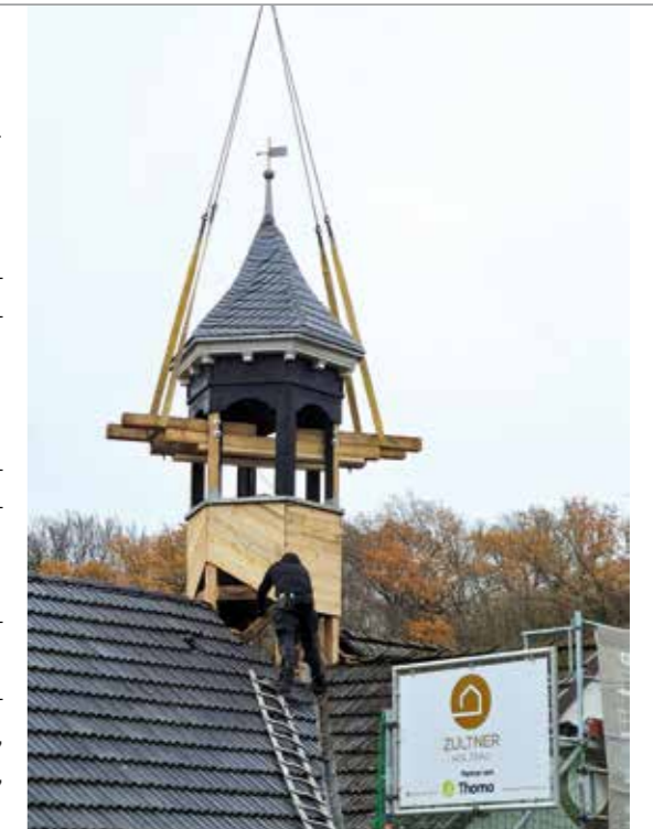
Mit dem Kran wurde erst der marode Turm nach unten transportiert und hier der sanierte wieder nach oben.
