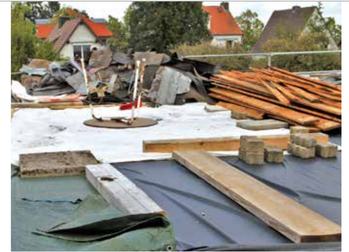
Mit Teichfolie, vorne rechts, installierte die Familie eine erste Notabdeckung, bevor später die Dachdecker kamen.
