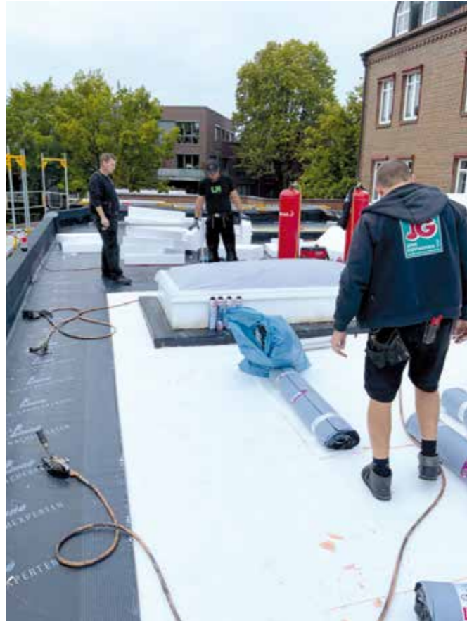
Flachdacharbeiten auf einem Gewerbeobjekt inklusive Lichtkuppeln.
