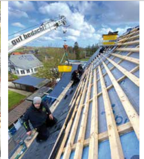
Kraneinsatz im Ortskern, um die Mitarbeiter direkt auf dem Dach mit Material zu versorgen.
