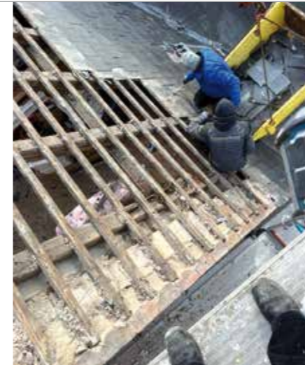
Marode Sparren zeigten sich beim Abriss der alten Eindeckung und wurden von den Mitarbeitern vor der Schiefereindeckung ausgetauscht.
