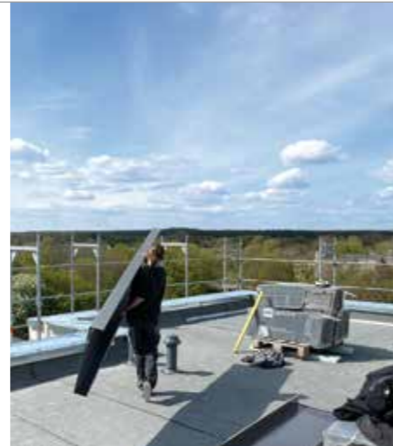
Girls'Day: Linda packt mit an bei der Mauerabdeckung auf dem Flachdach.
