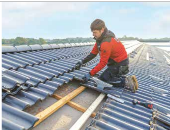
Die Solar-Trägerpfannen von FLECK lassen sich perfekt in bestehende Steildächer integrieren.
