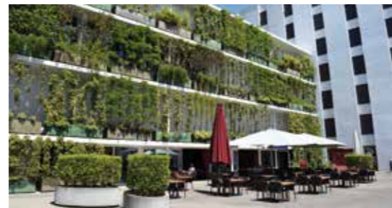
Fassadenbegrünung schafft ein mediterranes Flair.
