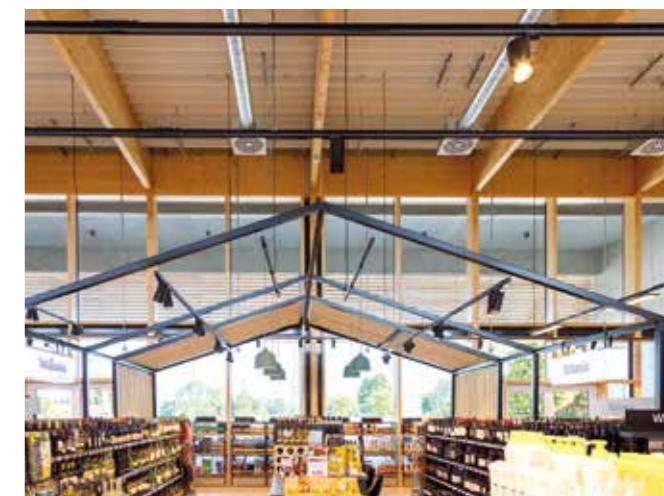
Innensicht: Insgesamt erstellte der Betrieb rund 5400 Quadratmeter Flachdach aus Trapezblechen auf Brettschichtholz.
