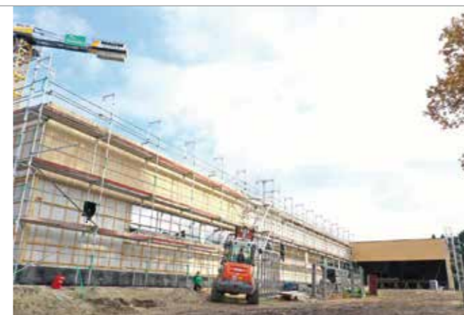
Auf die doppelschaligen, gedämmten Wände wird das Grundgerüst montiert, als Basis für die Lärchenholzfassade.
