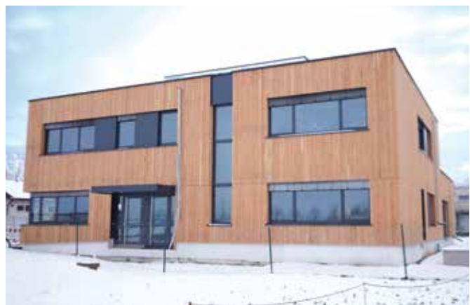
So sieht der Holzhybrid-Bau nach der Fertigstellung der schönen Fassade aus.
