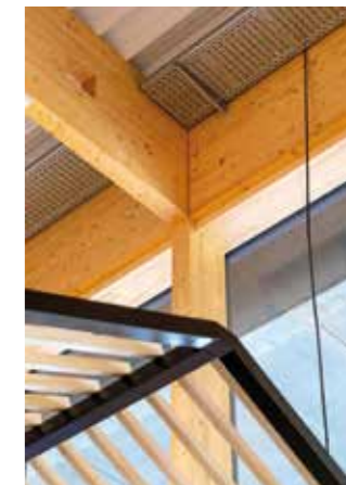
Detailansicht der tragenden Holzkonstruktion.
