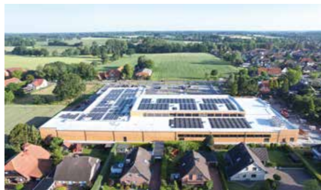
Flachdach nach Fertigstellung mit Folie, Dämmung und Dampfsperre. Für die Energiebeschaffung sorgt eine Photovoltaikanlage.
