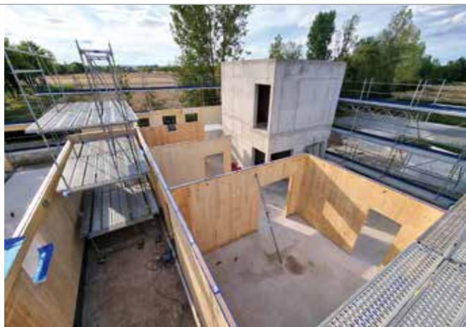
Tragender Stahlbeton wird im Inneren des Holzhybrids erstellt.
