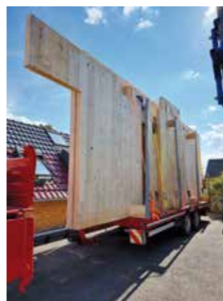
Nach der Zwischenlagerung im eigenen Betrieb gingen die vorgefertigten Holzelemente erst Monate später auf die Baustelle.
