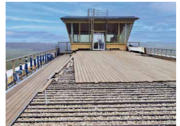
Kebony Dielen wurden als hochwertiger Belag verlegt.
