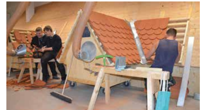
Arbeiten am klassischen Steildachmodell mit Biberschwanzziegeln.
