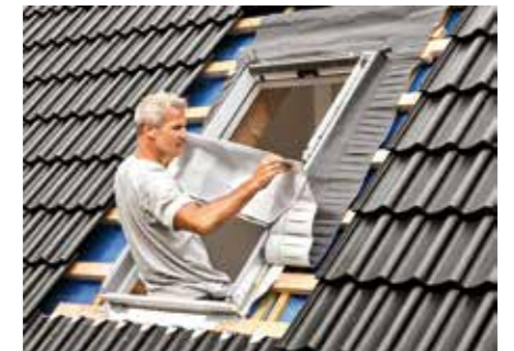
Die Anschlusschürze wird künftig im eingerollten Zustand geliefert und bei der Montage zunächst so über dem Fenster platziert und fixiert. Der Handwerker kann sie Schritt für Schritt ausrollen und in die benötigte Position bringen.
