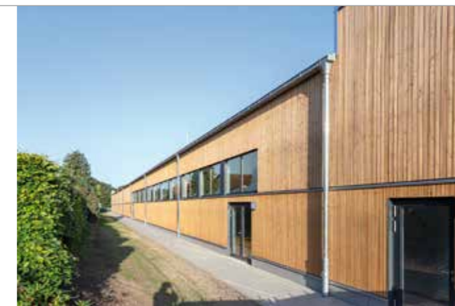
Fenster und Türen wurden fachgerecht mit eingebaut.
