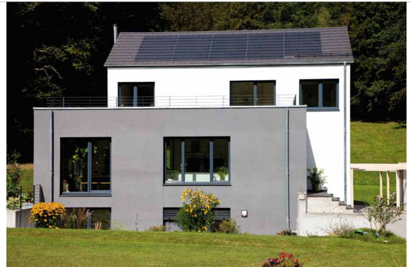
Solarenergie mit Design: Dachstein Tegalit und Photovoltaikmodule Braas PV Premium
