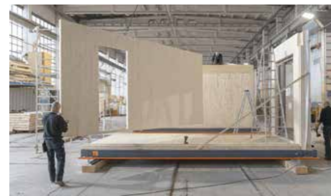
Vorfertigung der Büromodule (oben) und Zusammenspiel von Holz und Beton im Erdgeschoss.
