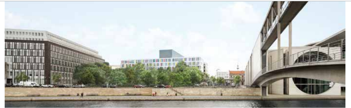
Der markante Holzhybridbau Luisenblock West liegt zwischen Paul-Löbe-Haus und Bundeskanzleramt (rechts).
