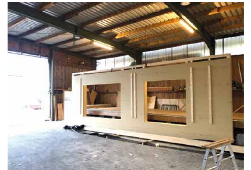
Inmitten der Fertigungshalle entsteht ein Versatzstück eines Holzrahmenhauses. Die Wand-fläche mit vorbereiteten Auslassungen für die Fenster ist klar erkennbar.
