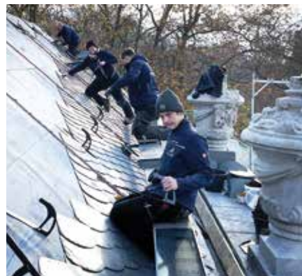
Dachdecken ist Teamwork – die Mitarbeiter von Reiner-Dach unterstützen sich gegenseitig.
