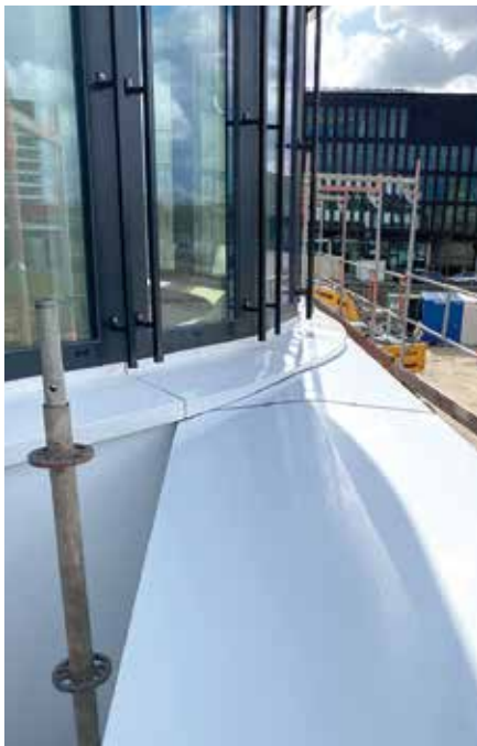
Beim Fraunhofer Institut verbaute Henke die Fassade so, dass die Kanten des Baus durch gerundete Alucobond Platten versteckt werden, das Ergebnis: Kein einziger 90 Grad Winkel
