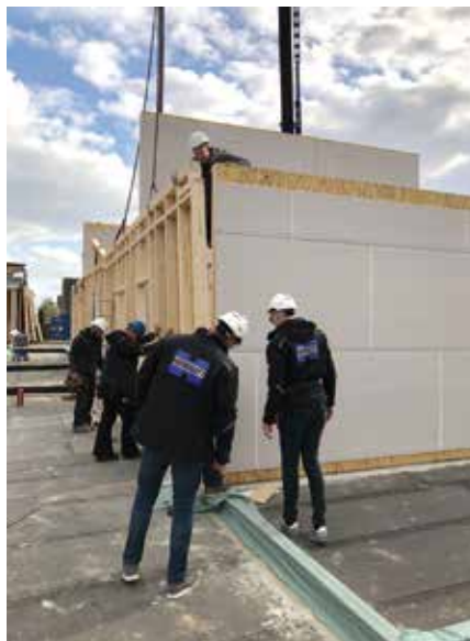
Welches Bauteil muss wo hin? Sechs Mitarbeiter führten die Montage durch.
