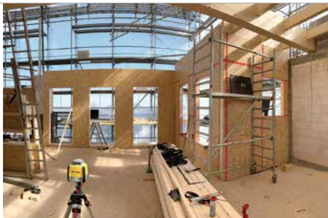
Ein gutes Beispiel für Wohnraumerweiterung ist eine Dachaufstockung im Zentrum von Hamburg.
