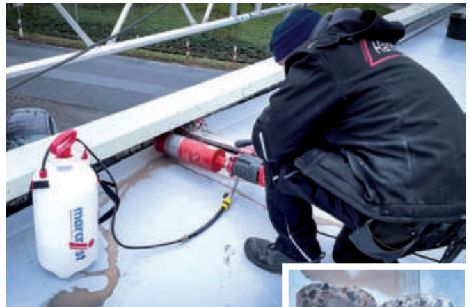
Praxisbeispiel 2 Kernlochbohrungen mit der WCU750X Ø 122 mm durch 200 mm Stahlbeton mit dem Compact Set, 12 min./Bohrung
