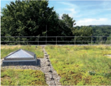
Viele negative Auswirkungen der Flächenversiegelung lassen sich mit einer Dachbegrünung als Ausgleichsmaßnahme deutlich mindern.
