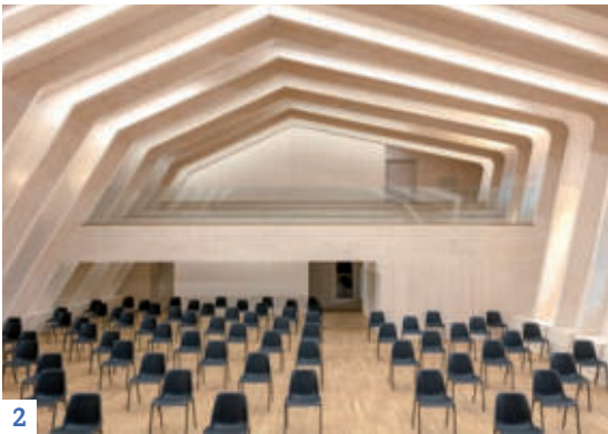
02: Die neue zweigeschossige Aula des Plattenbaus: eine Konstruktion aus BS-Holz-Rahmen.
