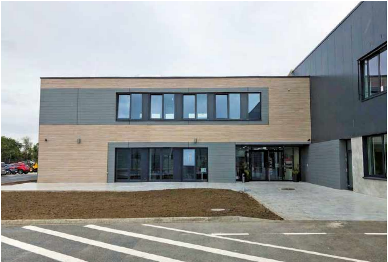
Neubau ZNL Dortmund / Bürofassade mit Dura Patina
