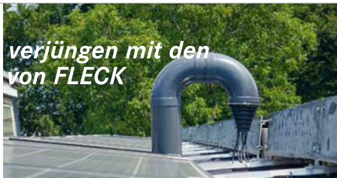
Die neuen Schwanenhals-Verschlussmanschetten von FLECK eignen sich hervorragend, um z. B. die Kabel einer PV-Anlage ins Gebäudeinnere zu verlegen.
