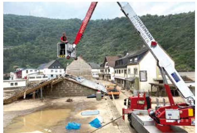
Ein Notdach installieren mithilfe des eigenen Firmenkrans.
