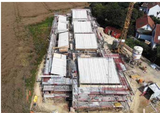
Ein Kitaneubau mit Sheddächern ist das nächste Projekt der Dachdeckerei Brummerhop.
