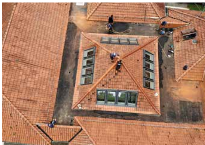
Die Sanierung der Dachfläche der großen Halle einer Grundschule ist gerade abgeschlossen.
