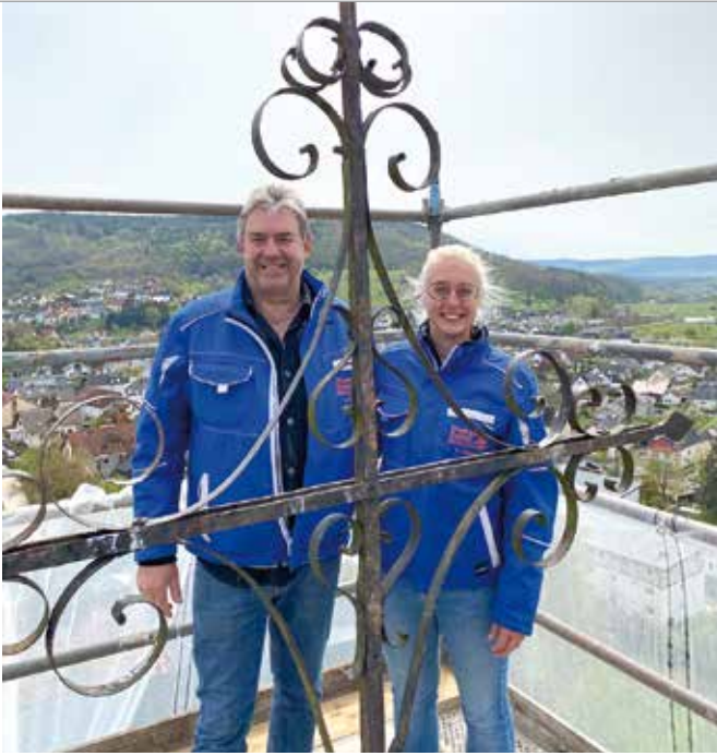
Vater Jürgen Thieltges hat seine Tochter schon als Kind mitgenommen auf die Baustellen.
