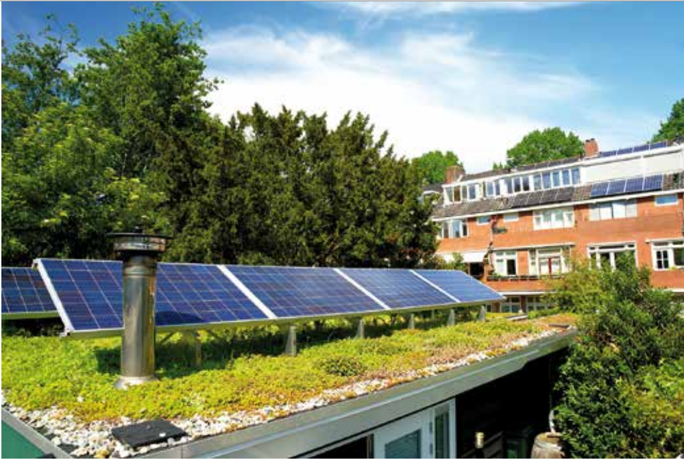
Die Kombination mit einem Gründach bringt durch Dachkühlung einen höheren Ertrag der PV-Anlage.
