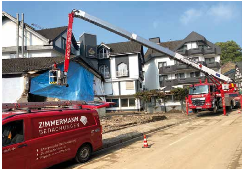
Zimmermann Bedachungen war einer der über 100 Dachdeckerbetriebe, die dem Aufruf von Bernd Kringinger folgten.
