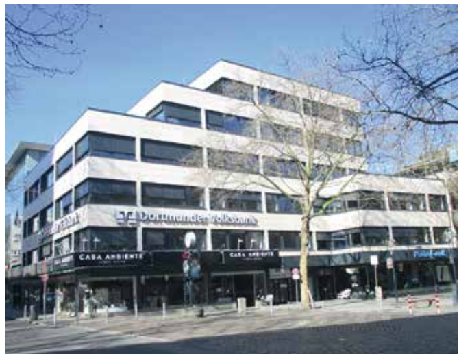
Vorzeigeobjekt Fassadenbau Volksbank Dortmund: Über solche Leistungen freuen sich alle der mehr als 60 Mitarbeiter (oben).
