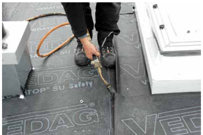
Flachdach: Vedag Bitumenbahnen in der Verarbeitung vor Ort
