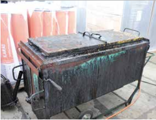
Der „Kochtopf“ auf dem Dach: zehn Tonnen Bitumen sind zu kochen.
