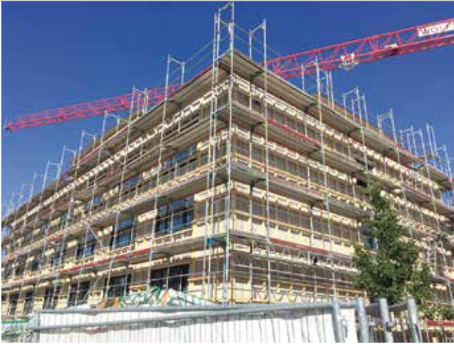
Sechs bis acht Mitarbeiter waren bis März 2020 praktisch ständig auf der Baustelle im Einsatz.
