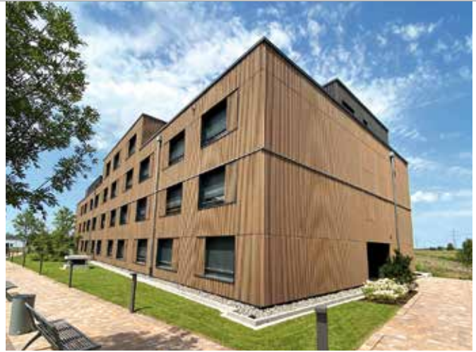
Auftrag ausgeführt: Die Holzfassade aus Lärche verleiht dem Mitarbeiter-Hotel ein optisch sehr ansprechendes Erscheinungsbild.
