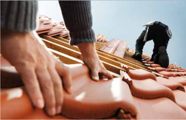
BMI will beim Steildach die Position als einer der Marktführer im Bereich Innovation und Service erhalten und ausbauen.
