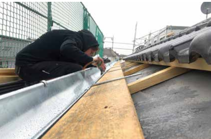
Feinschliff an der Dachrinne: Larissa Würtenberger steht auf Genauigkeit.
