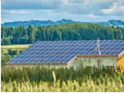
Strom vom Dach: Mit PV-Modulen ausgestattete Dach- flächen sorgen für saubere Energie.
