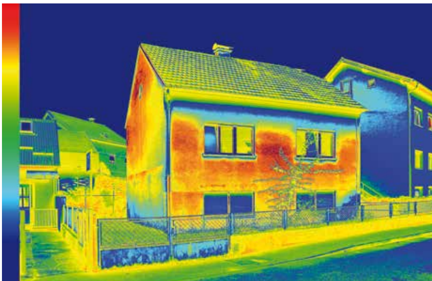
Dämmen spart: In Wohngebäuden ist die Raumwärme Energiefresser Nummer eins.
