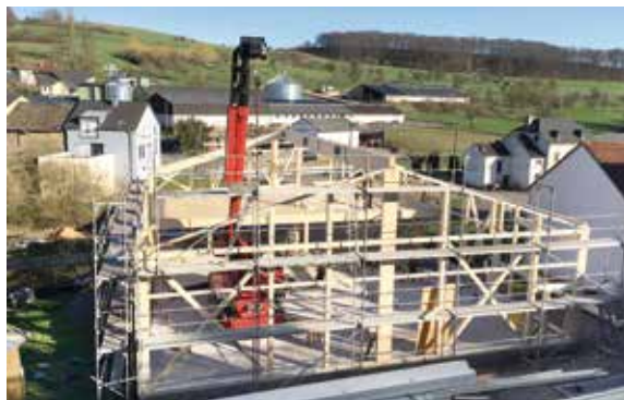
Mit Hilfe eines Krans wurden die vorgefertigten Holzbalken ins Innere der Halle transportiert.
