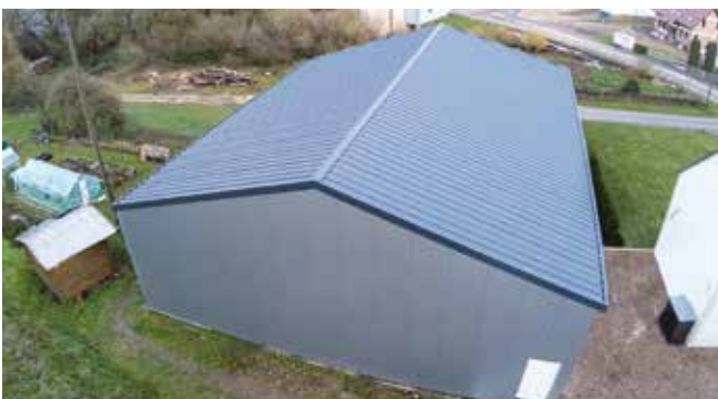
Sandwichpaneele in grauer Farbe wurden für die Fassade gewählt. Von außen ist die Holzkonstruktion nicht sichtbar.
