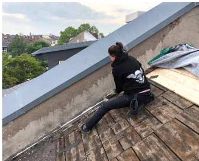
Vorbereitende Arbeit für die Dachsanierung
