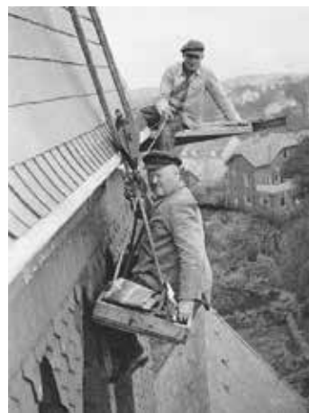
Hermann Krapp bei Arbeiten am Kirchturm 1935
