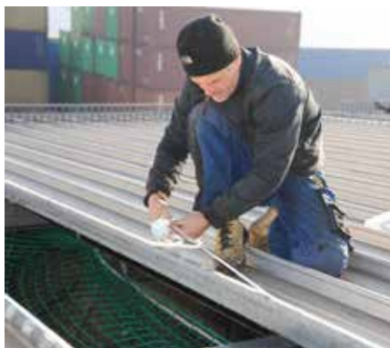
Kräftige Hagelschauer haben die in die Jahre gekommenen Lichtbänder stark beschädigt. Nach erster Notabdichtung werden sie nun auf einer Länge von circa sieben Kilometern durch neue Kalzip-Lichtbänder ersetzt.
