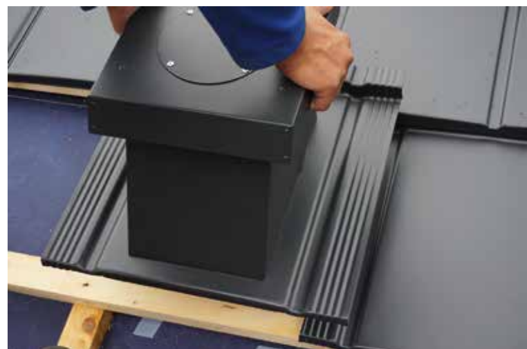
Verlegung des neu entwickelten Dunstrohrlüfters. Für Plano sind alle Zubehöre komplett aus Metall gefertigt. Dadurch werden die Wertig- und Haltbarkeit wesentlich gesteigert.
