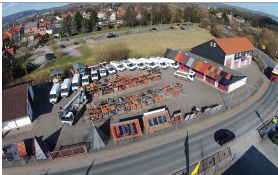
Das Junker Betriebsgelände von oben
