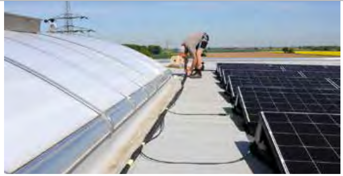
Sechs Kilometer Kabel waren zu verlegen und zu verbinden. Die Lagesicherheit der Unterkonstruktion erfordert weder Ballast noch eine Durchdringung.
