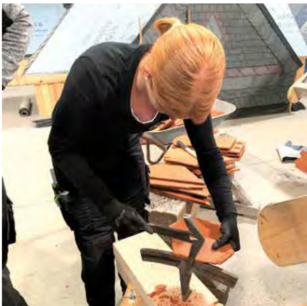
Vorarbeiten für das Dachmodell: Zuschneiden der Dachziegel
