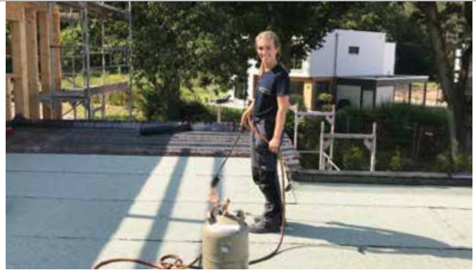
Beim Schweißen auf dem Flachdach: „Muss ich noch üben...“, sagt die Dachdeckerin.
