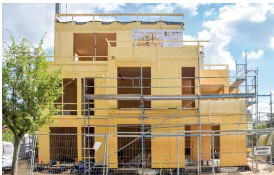
Das Zweifamilienhaus in Holzbauweise nimmt Gestalt an.
