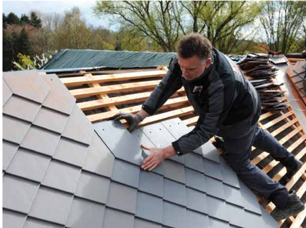
Eindeckung des Dachs mit dem neu entwickelten Tonziegel
