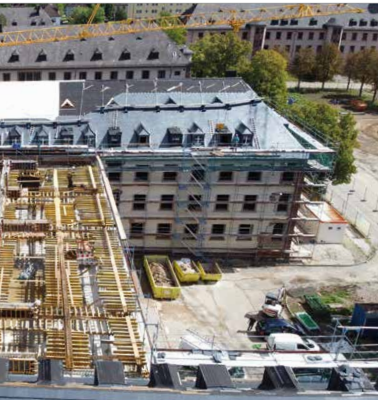
Große Dachflächen gilt es, im neuen Stadtquartier Campbell Barracks mit Schiefer einzudecken.
