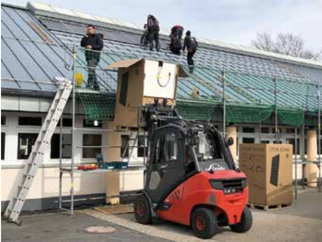
Arbeiten Hand in Hand in entspannter Atmosphäre: ehrenamtliches Engagement für die Dachdeckerschule Lehesten.
