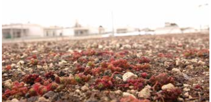
Die Gründach-Bepflanzung frisch aufgeschüttet
