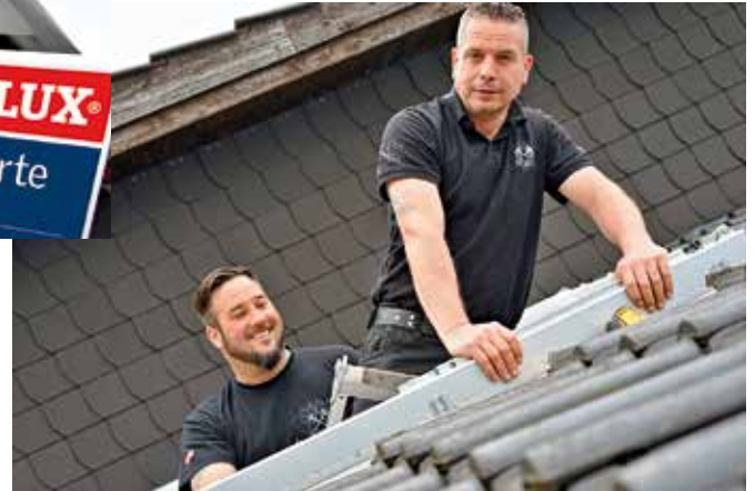
unten: Die Mitarbeiter Dennis Frerking (links) und Enco Pfarr bereiten ein Dachfenster für den Einbau vor.
