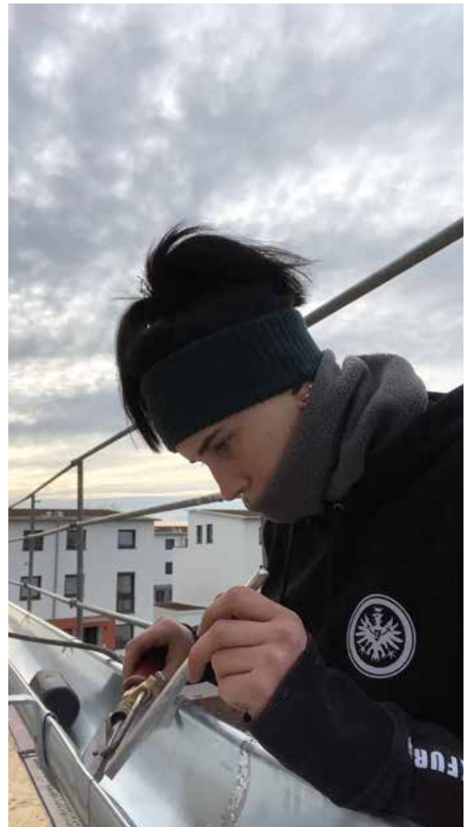
Genauigkeit bei der Arbeit ist eigentlich eine der Stärken der Dachdeckergesellin.
