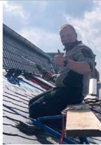
Auch Schieferexperten arbeiten bei Hermann Dachbau.
