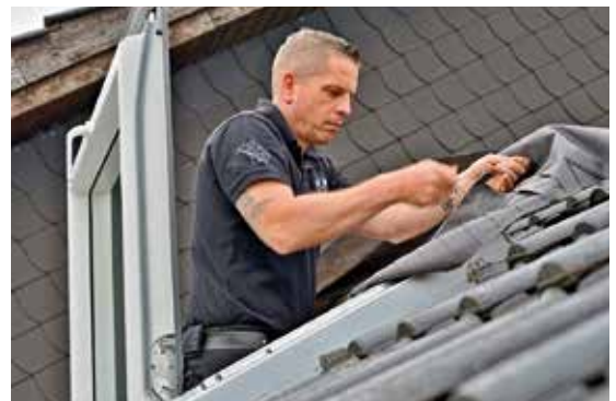
Die Mitarbeiter Dennis Frerking (rechts) und Enco Pfarr sind Profis für den Dachfensteraustausch.
