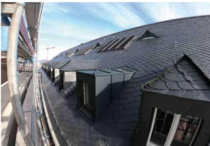
Filigrane Schiefereindeckung realisiert an einer der vielen Gauben.
