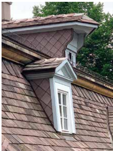
Detailansicht des neues Dachs mit Gauben am Schloss Bad Pyrmont.
