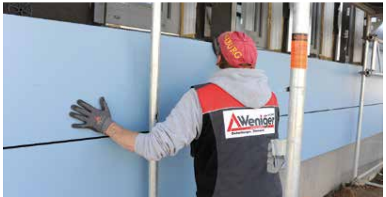
Es gilt, die Fassadenplatten genau zu justieren, bis alles fest verklebt ist.
