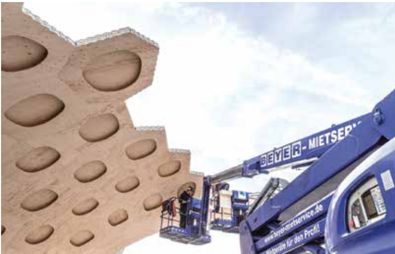
Die Schale wurde im freien Vorbau aufgebaut.
