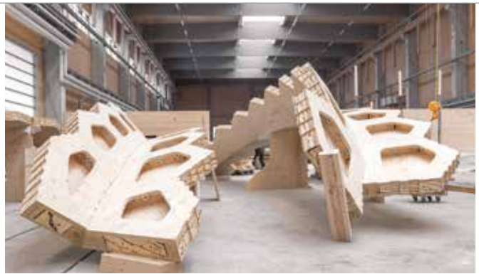
oben: Die Kassetten der 3 Bögen werden im Werk vormontiert.
