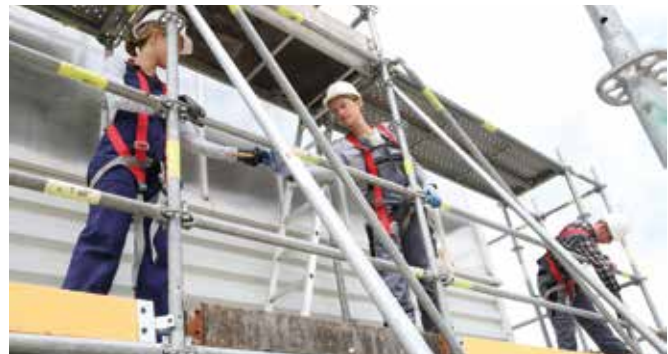
Ohne sicher und korrekt aufgestellte Gerüste sind viele Dacharbeiten kaum durchzuführen.
