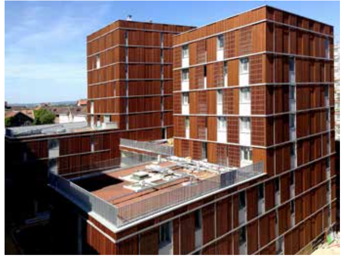
Fassade, imprägniert mit Koralan® Holzöl Spezial
