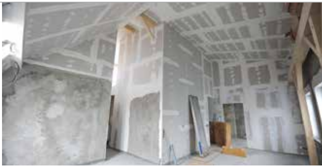
Innenausbau erfordert genaue und disziplinierte Arbeitsweise. Brandschutzwände wurden eingesetzt und die Rigipsplatten wurden vor Ort passgenau zugeschnitten.
