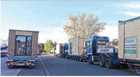
Logistische Herausforderung: Anlieferung mit Auflieger und Kran
