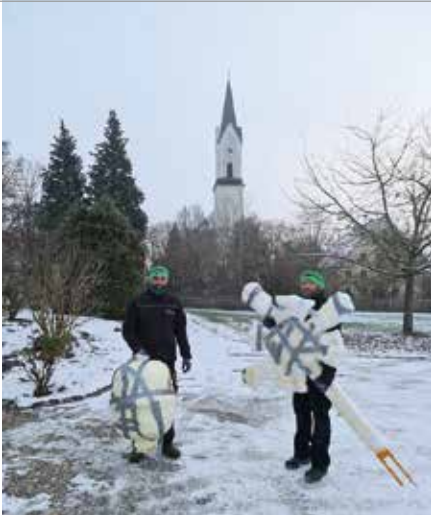
Dick verpackt brachten die Mertl-Mitarbeiter die neue Kugel und das neue Kreuz zum Einsatzort.
