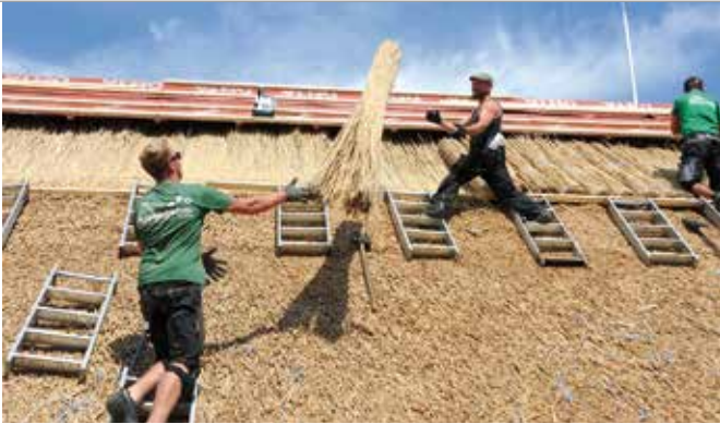
Mit 3.400 Bündeln Reet wurde das Dach des über 200 Jahre alten Bauwerks saniert.
