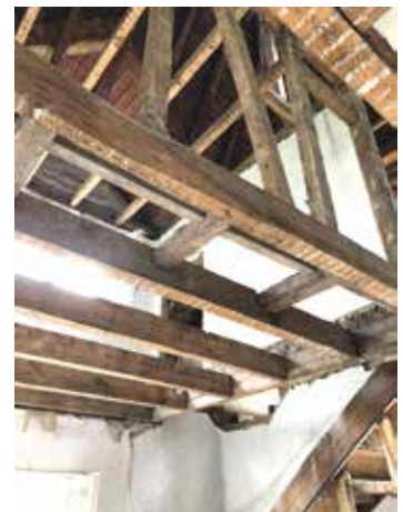
Zahlreiche Deckenbalken unterhalb des neuen liegenden Dachstuhls mussten ausgetauscht werden.
