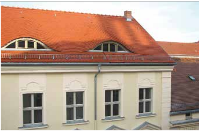
Die Fluchtweggaube fügt sich optisch ansprechend ins Ziegeldachbild ein.
