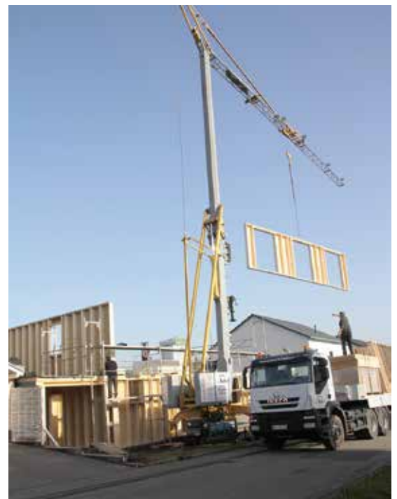
Mit dem eigenen Kran werden die Holzwände auf die Baustelle transportiert.
