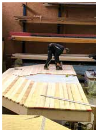
Ein Blick in die eigene Vorfertigung im Betrieb Reh (links).
