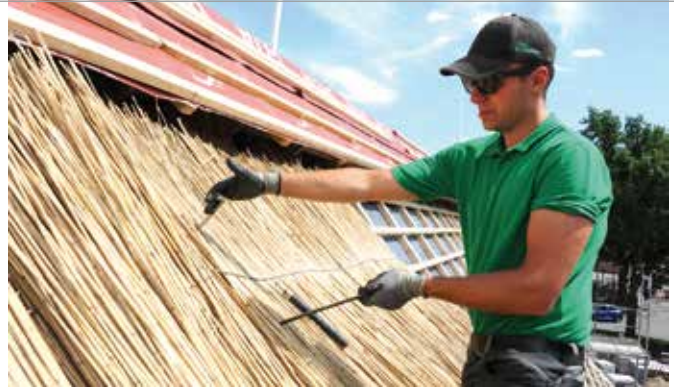
Mit krummer und gerader Nadel wird das Reet befestigt.
