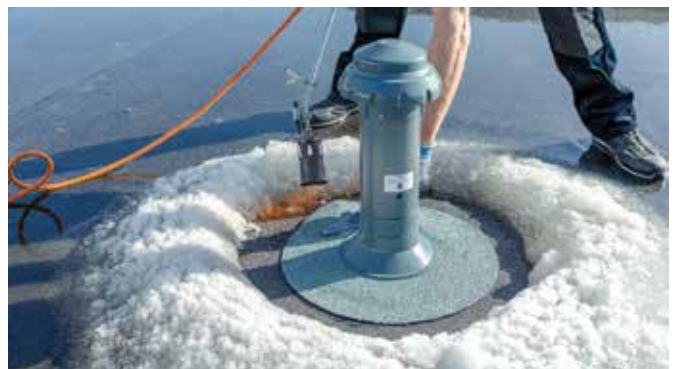
Das neue ROOF SUPER DRY ermöglicht eine Vielzahl an Reparaturarbeiten am Flachdach, wie zum Beispiel das Einsetzen eines 4 in 1 Flachdachlüfters, auch bei stehendem Wasserpfützen durchzuführen.
