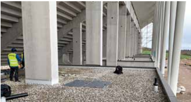
Blick vom Dach eines der Kioske unter einer Tribüne
