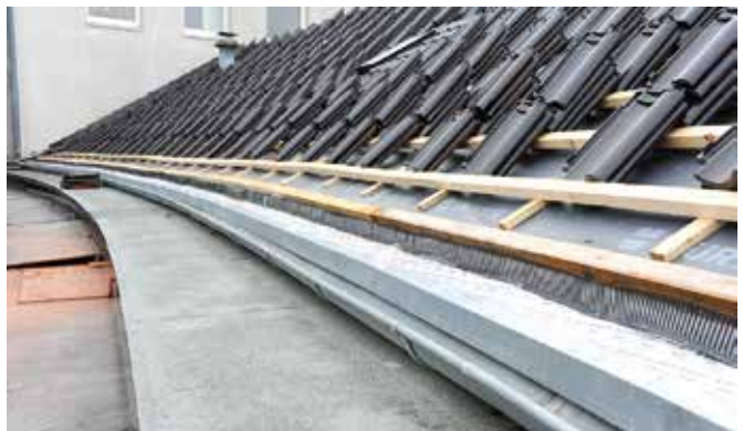
Die Deckung für die Innenrundung erweist sich immer einfacher als für die Außenrundung.
