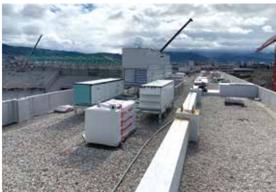
Übersicht vom Hauptgebäude, dessen Dach die Peter Gerber GmbH abgedichtet hat.
