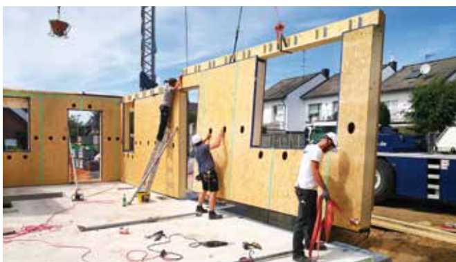
Auch Architektenhäuser werden von der Zimmerei Brönnecke in Holzrahmenbauweise realisiert.
