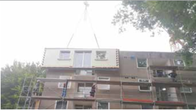
Das neue Modul wird an die vorbereitete Wand des Altbaus gesetzt.
