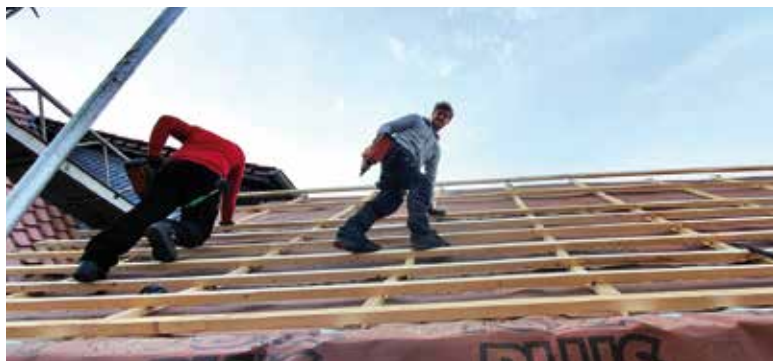
Die Übergänge zum Haupthaus erforderten einiges Geschick und konzentriertes Arbeiten.
