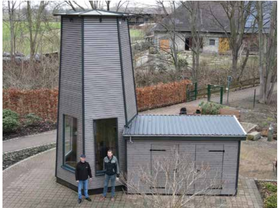
Karsten Jütte (links) und Bastian Bühlbecker vor dem sanierten Pumpenturm in Westernkotten.
