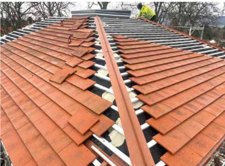
Verlegung der speziellen, wasserdurchlässigen Tonziegel.
