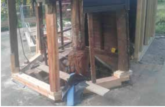
Turm und Pumpenhäuschen mussten von Grund auf erneuert werden.
