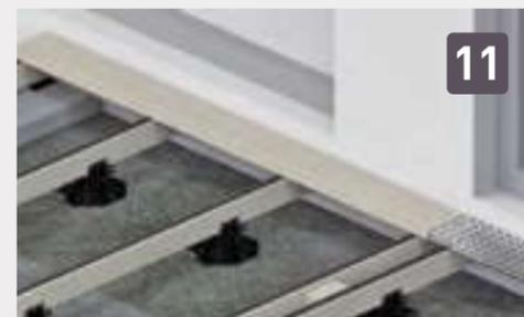
11. Montieren Sie die erste Terrassendiele sowie den Entwässerungsrost beziehungsweise die Entwässerungsrinne mit rund 20 Millimeter Abstand zur Hauswand.
