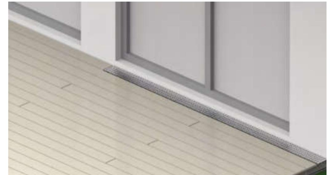
Nach den Regelwerken muss immer ein Entwässerungsrost eingebaut sein, wenn kein Höhenunterschied von 150 Millimeter einzuhalten ist. „Bei einer Ausführung ohne Regenrinne auf dem Niveau des dahinterliegenden Bodens, müssen bei Starkregen und Schnee geeignete Maßnahmen ergriffen werden, damit keine Feuchtigkeit eindringen kann“.
