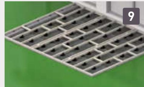
9. Wenn alle Unterkonstruktionen an der Rahmenkonstruktion angeschraubt sind, richten Sie die Verstellfüße exakt aus.
