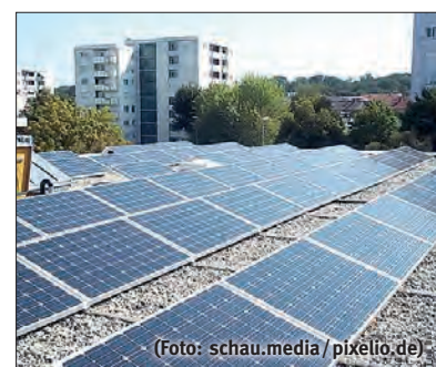
Auf dem Schulhausdach in Fiesch ist der Bau einer Solarstrom-Anlage geplant.
